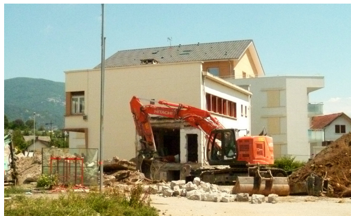
Démolition de l'ancienne extension
